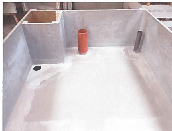
Foto 6. Vandtætningsmembran er ved at blive påført – hjørner mv. er strimlet.
