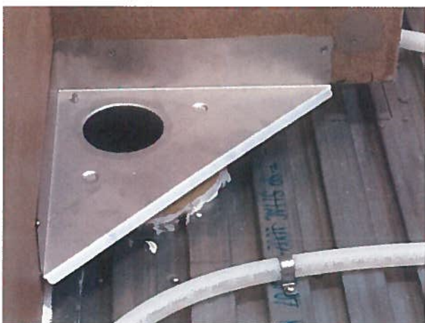
Foto 3. Montering af hjørneafløb.
