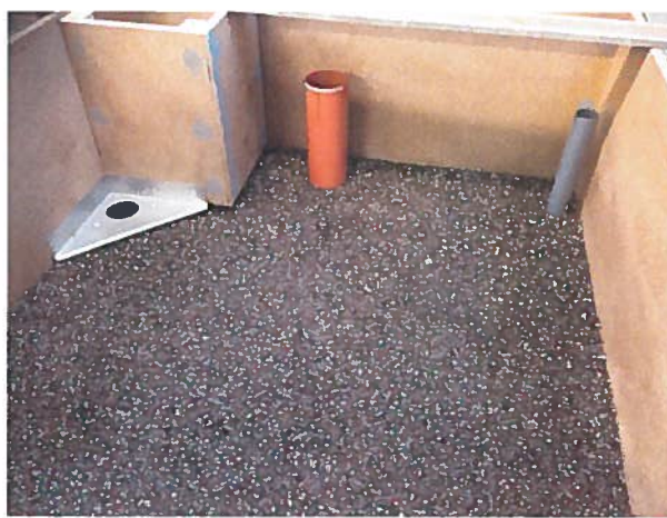
Foto 4. Udstøbning med LIP Thermodyn.
