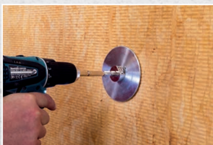
Når verktøyets krage er i flukt med isolasjonen, er monteringen av dyvelen ferdig
