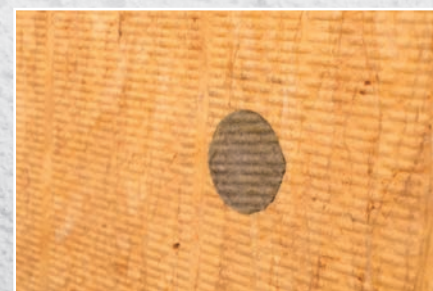
Isolasjonsoverflaten er nå klar til grunnpuss.
