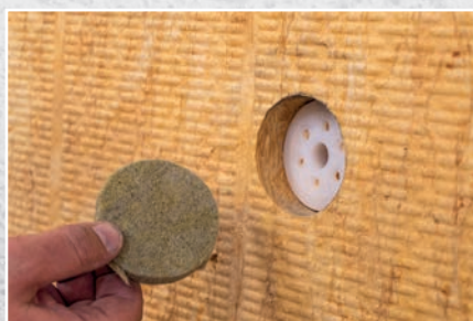
Passende isolasjonssrondell monteres.
