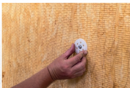
Termodyvelen settes i plan med isolasjonsoverflaten.
