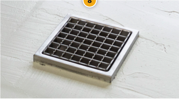
2K vådrumsmembranen er udført.
