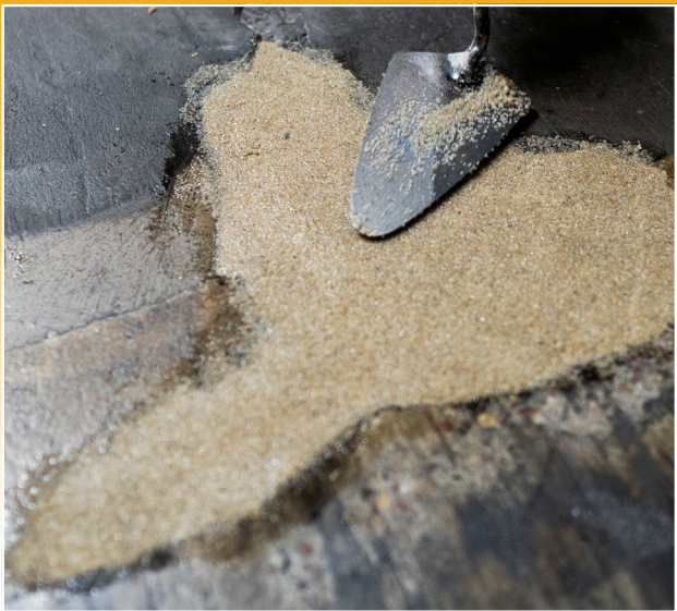
Fugning af flisebelægning.
