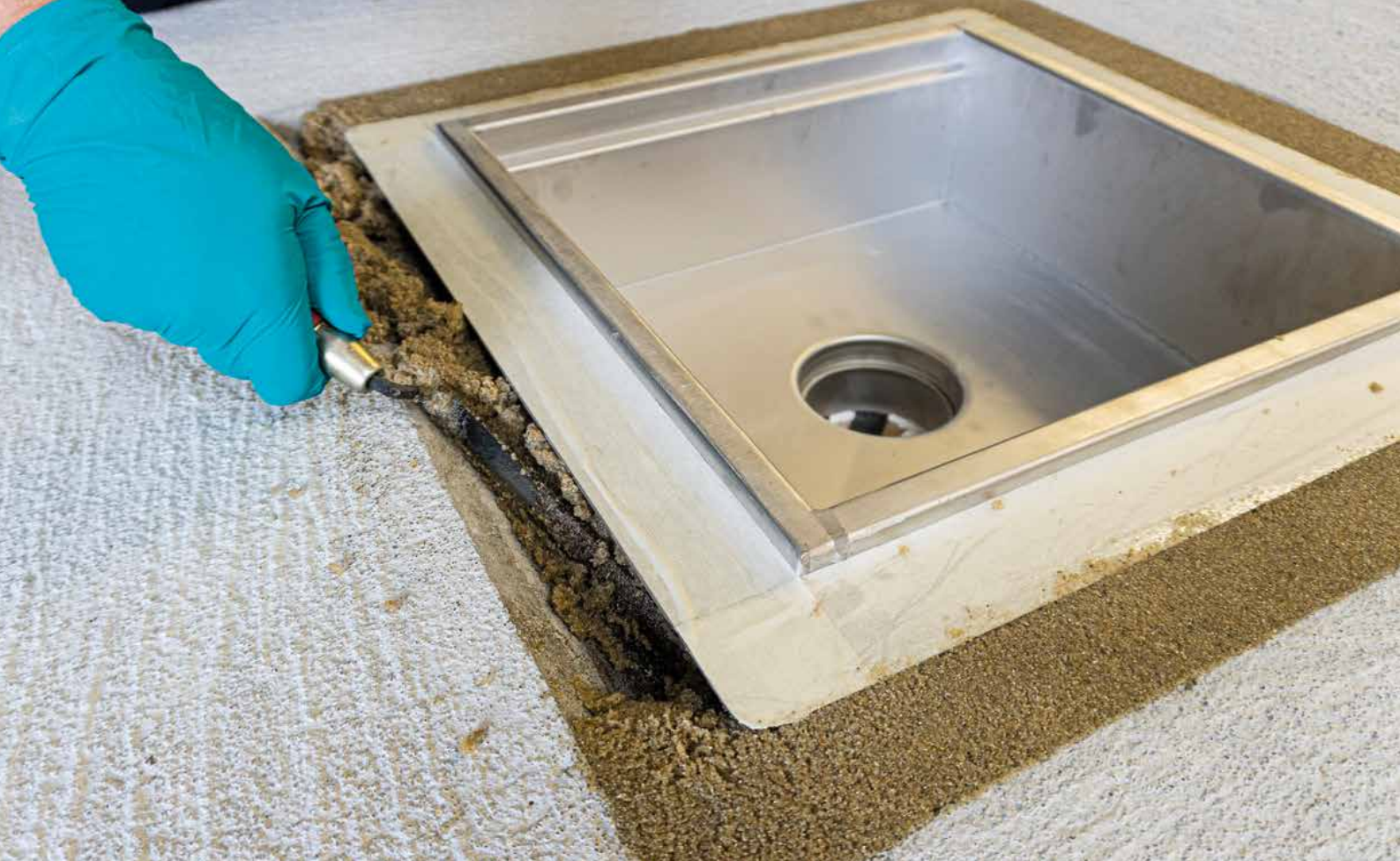
► Installation av LIP 25 Epoxi-Kapillärbrytare.
