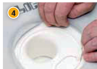
4. Se till att trycka fast tätarket och arbeta bort luftblåsor. Forma tätarket efter golvbrunnen.
