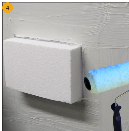
När limmet torkat minst 1 timme appliceras LIP 2K Folielim på plastflänsen med LIP Folielimspackel eller roller/pensel (samma monteringsmetod gäller för spolröret). Övriga väggytor appliceras enligt valt system (se monteringsanvisning för valt system).
