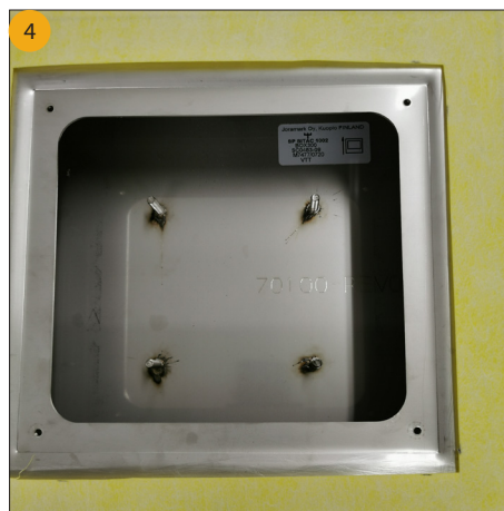
4 Tätskiktet ska överlappa ca 4 cm ut på inbyggnadslådans ram fram mot öppningen.
