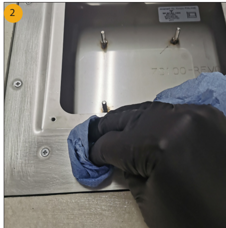
2 Rengör flänsen med Rödsprit (T-röd) och ren trasa. För att uppnå optimal fäststyrka ska alla ytor vara rena och fria från smuts (t.ex. damm, Primer, fett). Låt torka i ca. 20 minuter.
